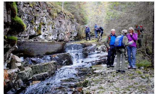
Demning i Urselven for vannledning
